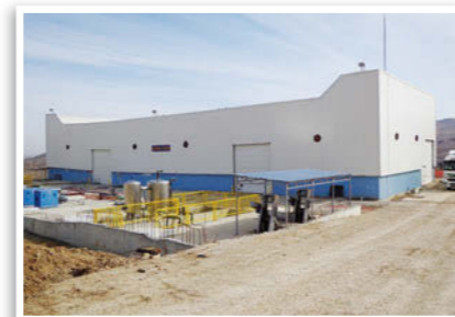
排水処理設備(トルコ工場)
